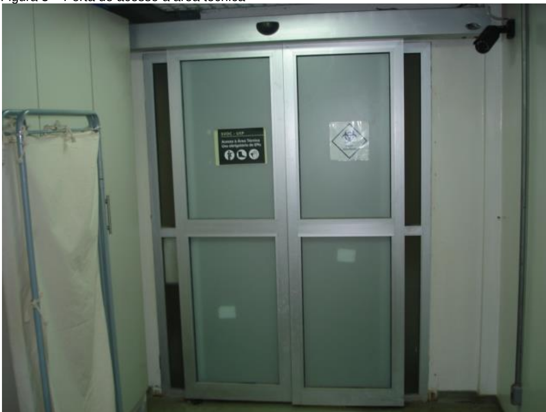
Figura 3 – Porta de acesso à área técnica
